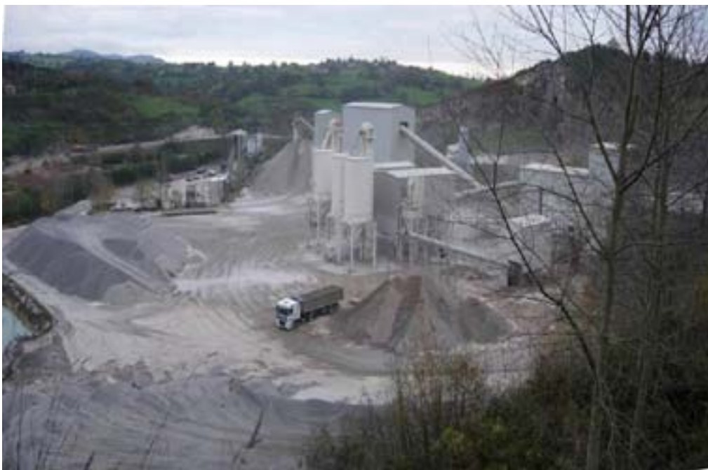
Figura 2 Instalaciones Cantera La Belonga
