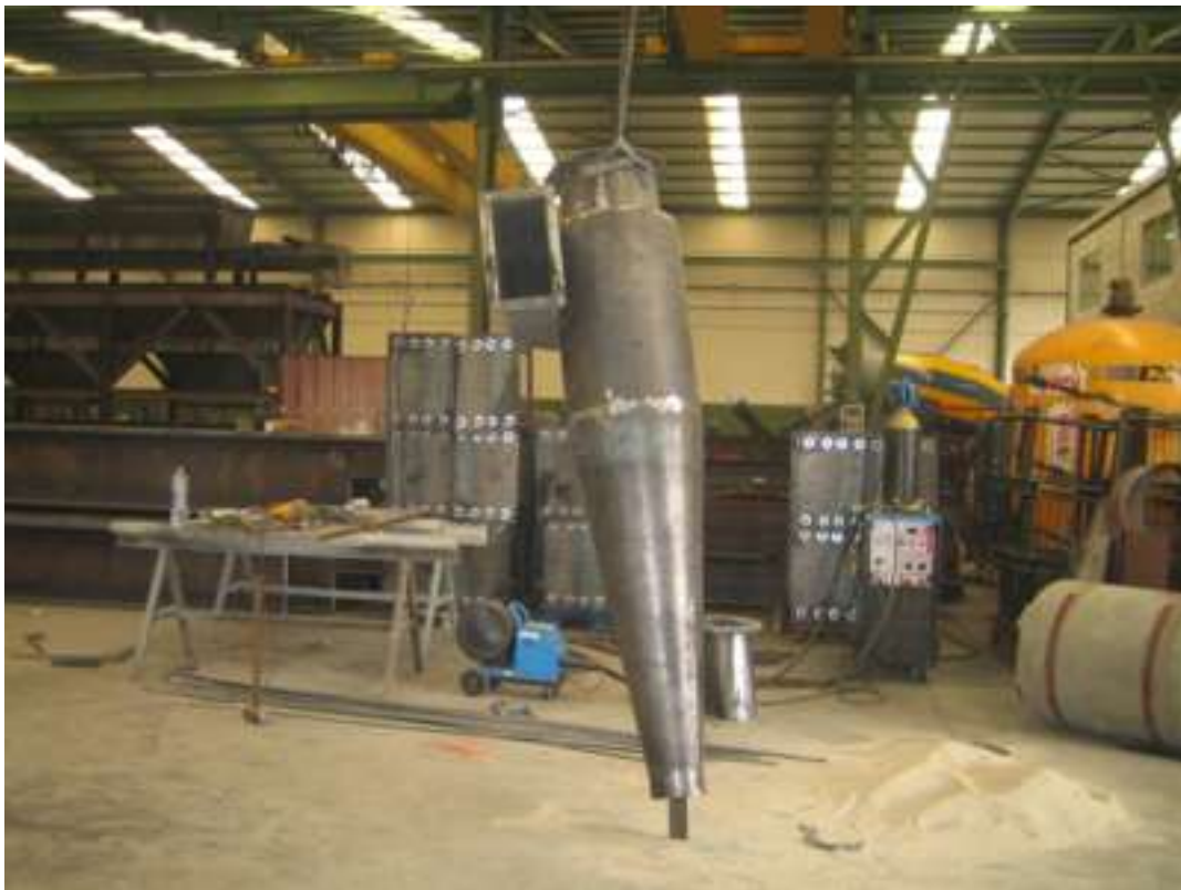
Figura 7 Ciclón en construcción
