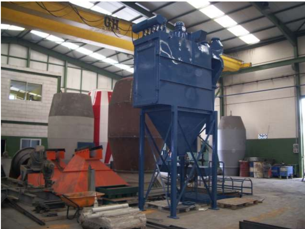
Figura 8 Unidad de filtrado en construcción
