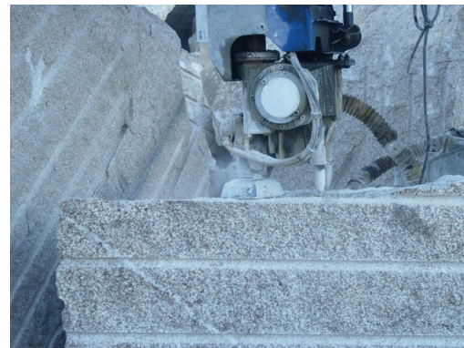
Fig. Captación localizada en la perforadora
