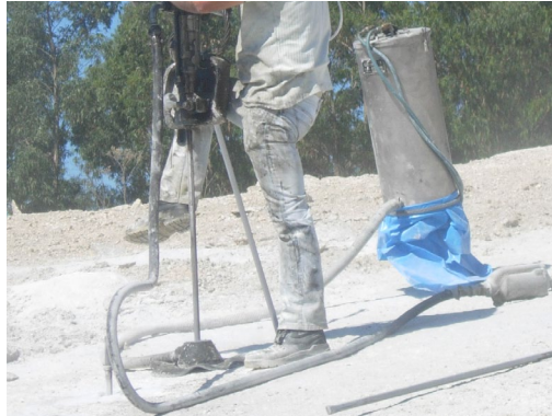
Fig. Perforación manual con captación
