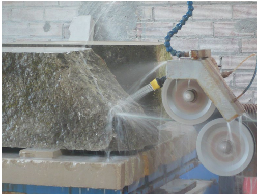
Fig. Las tareas de corte de bloques como parte inicial del proceso se realizan siempre con agua, con el fin de optimizar la vida del útil de corte. En los casos en que se cuente con boquillas dirigidas al punto de corte, deberá velarse porque se aplique el agua en el punto de generación de polvo, pues una desviación de milímetros puede restarle eficacia.
