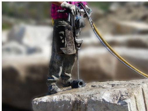
Fig. Perforación manual con uso de agua
